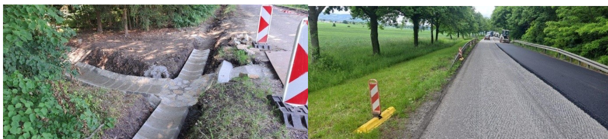
Rekonstrukce propustků
