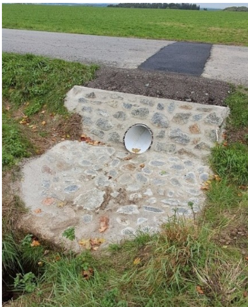
Malý silniční propustek evidenční číslo 13777-3P – provedeno vlastními silami
