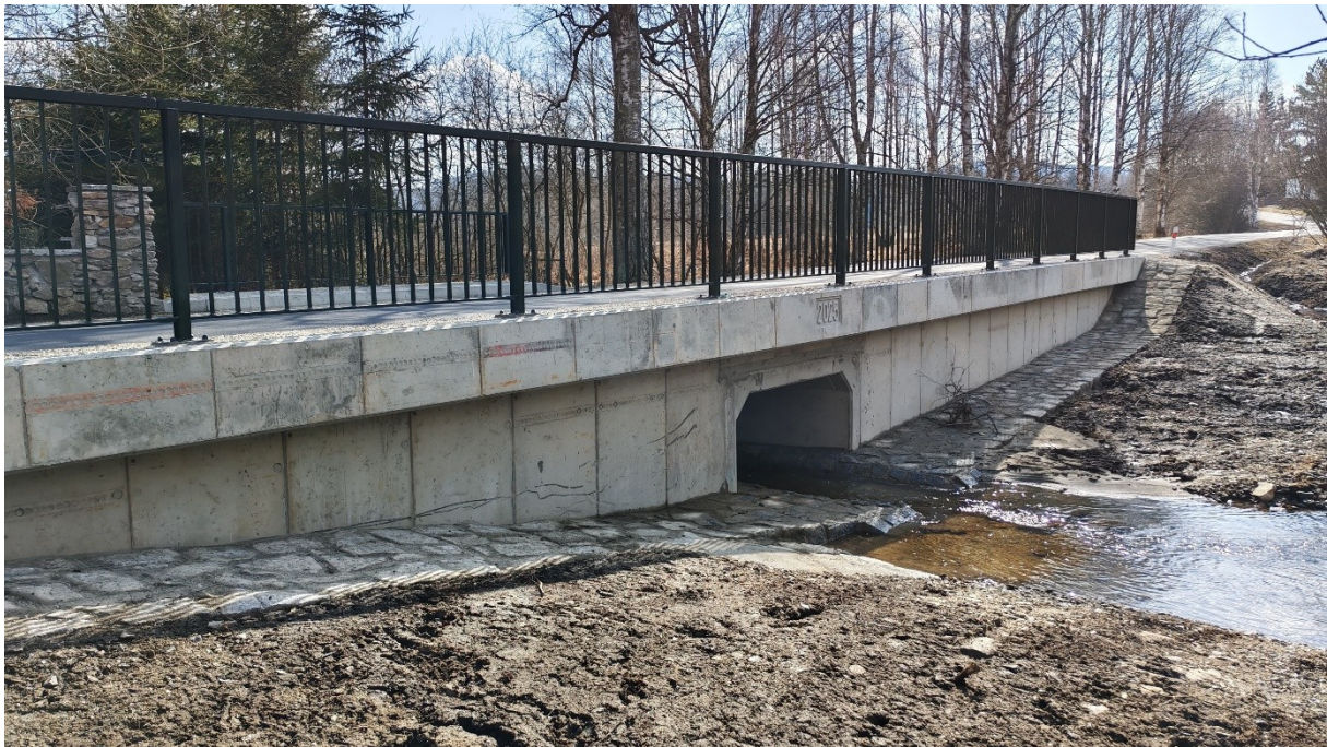
Rekonstrukce propustu pod sil. III/14144 přes Houženský potok
