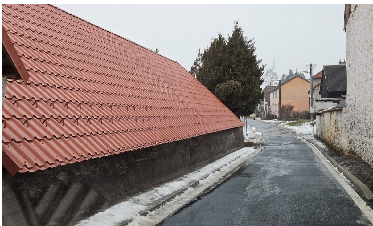
Silnice III-12417 Stojslavice-dokončená oprava vozovky po podchycení sousední nemovitosti.
