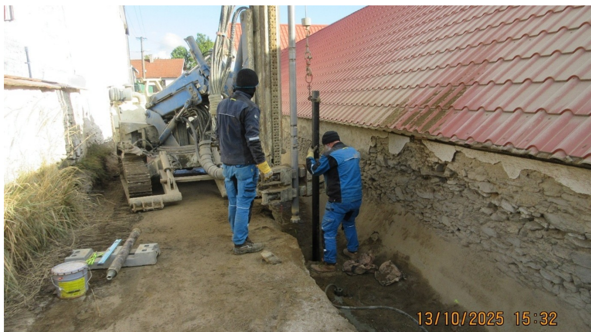
Silnice III-12417 Stojslavice – podchycování sousední nemovitosti.
