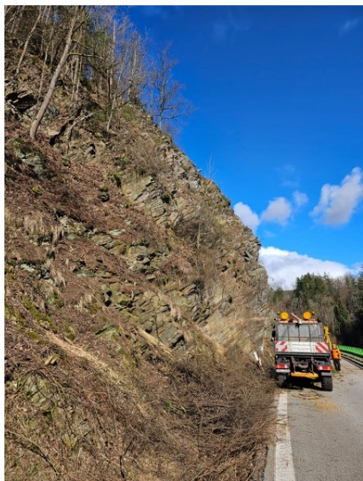
Vyřezání vegetace ze skal před realizací zabezpečení skalního masivu
