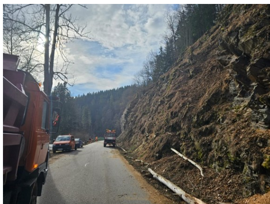
Vyřezání vegetace ze skal před realizací zabezpečení skalního masivu
