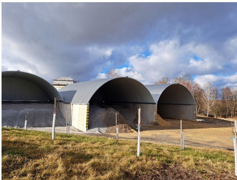
V roce 2024 bylo provedeno zastřešení boxů na inertní posypy na závodě Jindřichův Hradec.
