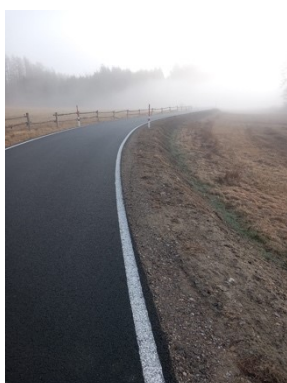
Stabilizace silničního tělesa, zřízení nezpevněných krajnic
