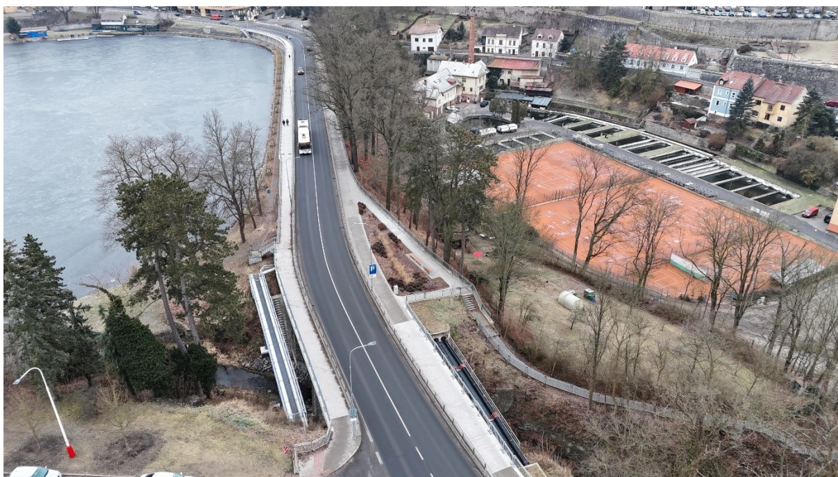
Most ev. č. 603-060 přes přepad rybníka Jordán v Táboře
