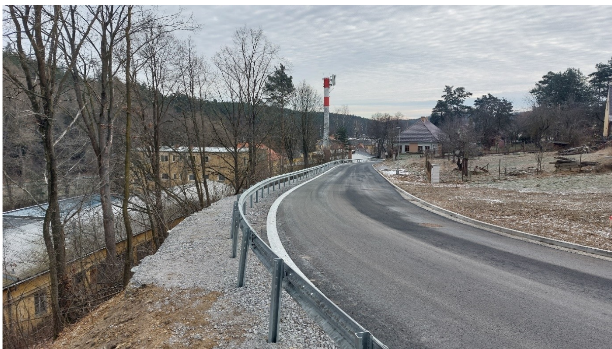
Rekonstrukce sil. III/14310 a stabilizace svahu Holubov
