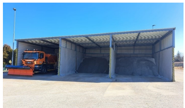
Přístřešek na boxy posypových materiálů – skládka Ševětín
