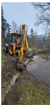
Rekonstrukce propustků před akcemi SFDI
