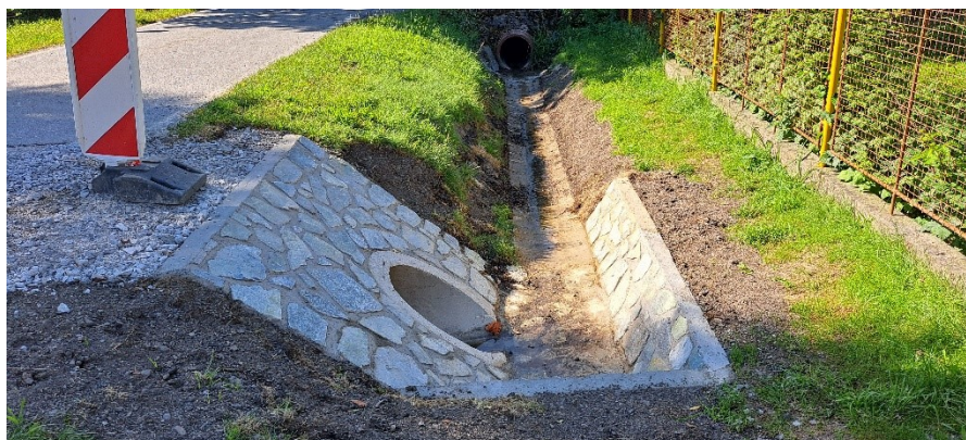
Rekonstrukce propustků
