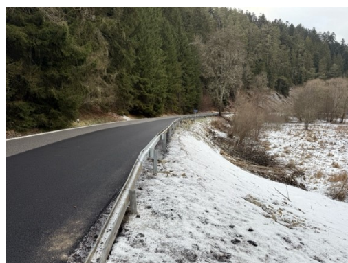
Stabilizace silničního tělesa, zřízení nezpevněných krajnic
