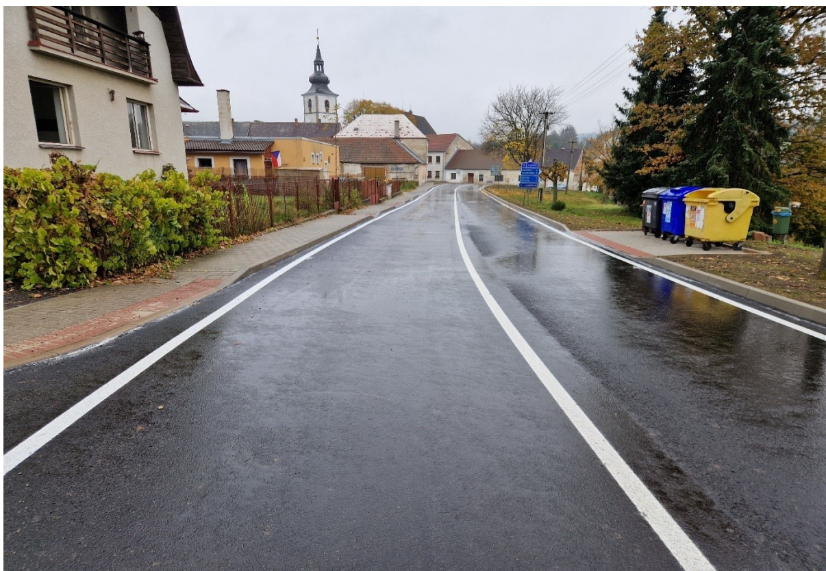
Silnice II/152 v průtahu Staré Město pod Landštejnem
