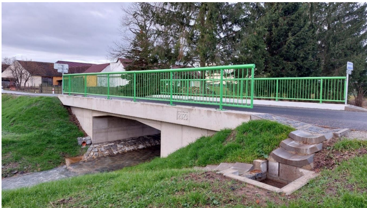
Obr.: Most ev. č. 14712-1 přes stoku před obcí Sedlíkovice
