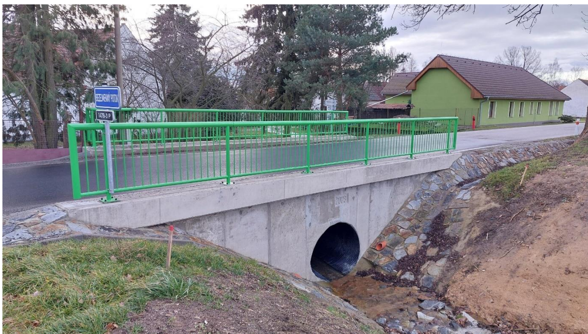
Obr.: Rekonstrukce propustku na sil. III/1478 v obci Popovice
