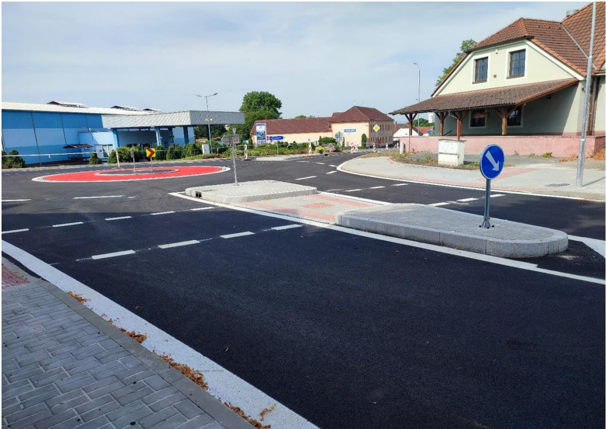
Obr.: Stav. úprava křiž. II/138 a II/141 v obci Temelín
