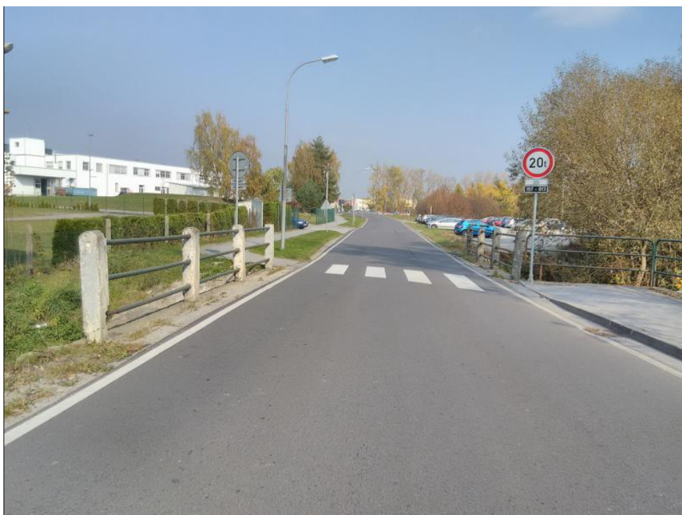
Obrázek 3 Prostorové uspořádání na mostě ev. č. 157-013
